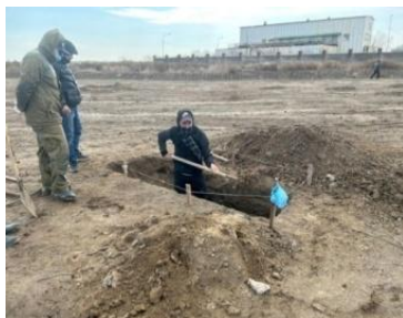
4,5,6-суреттер – Тәжірибелік алаңның топырақ жыныстарының геологиялық құрылымын анықтау үшін шурф орнату жұмыстары мен вертикальді қимасының геологиялық кескіні
